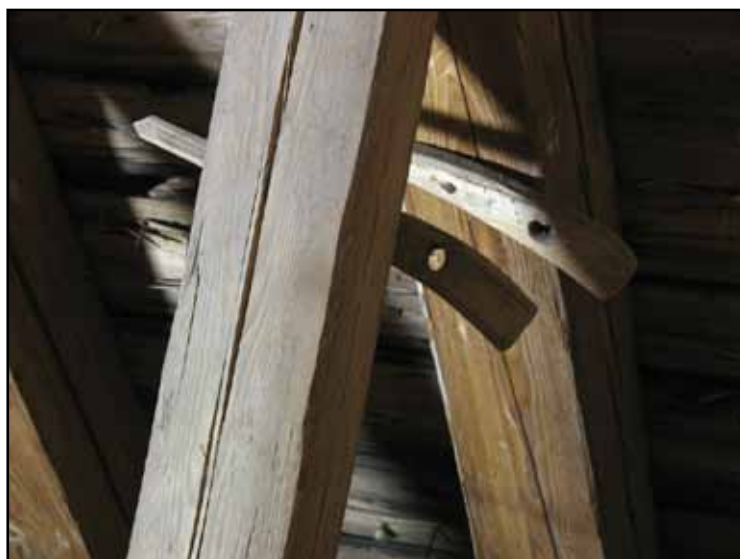
Spår av klockupphängning (?) på takstol invid korgaveln.
