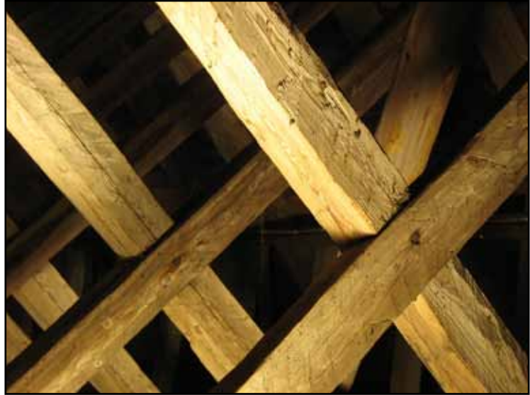
Hopfogningar med bladning och spik, ovan mellan högben och sparrar, till höger mellan de korsande sparrarna.
