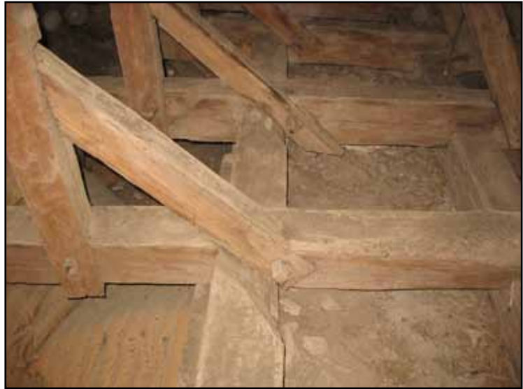
Sammanfogning mellan remstycken, tassar, sparrar och stödben. Notera urhuggningen i remstycket för infästningen av sparrarna. Kan detta vara ett tecken på att remstyckena är äldre?
