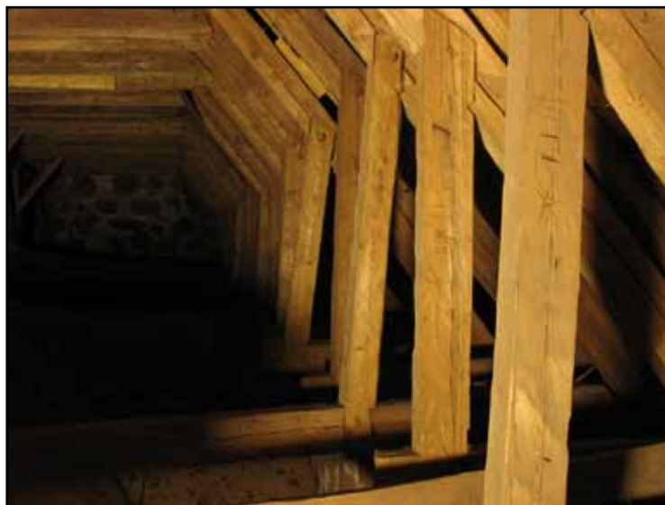
Knäbockar på taklagets södra sida. Alla bladningar är utförda med nacke och alla delar är noggrant märkta.
