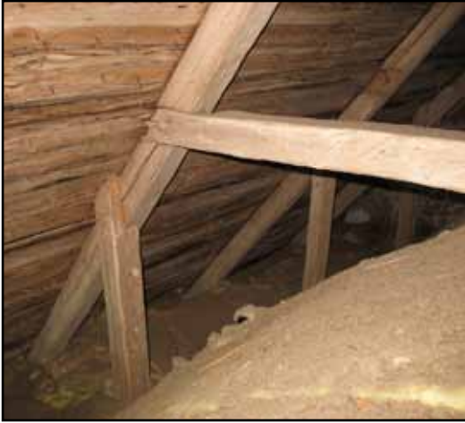
Knäbockskonstruktion.
