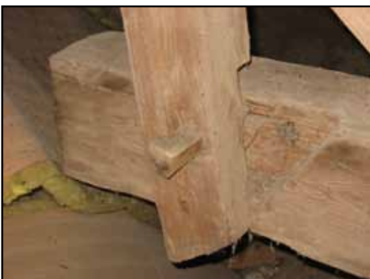
Infästning stödben i tass. Några av tassarna i nordväst har spår av äldre bladningar som också talar för en ombyggnad.
