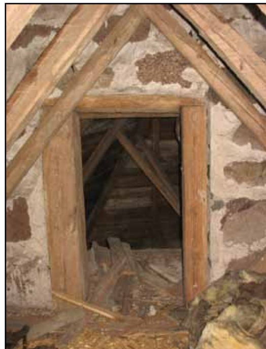
Väl utförd öppning in mot absidvind.
