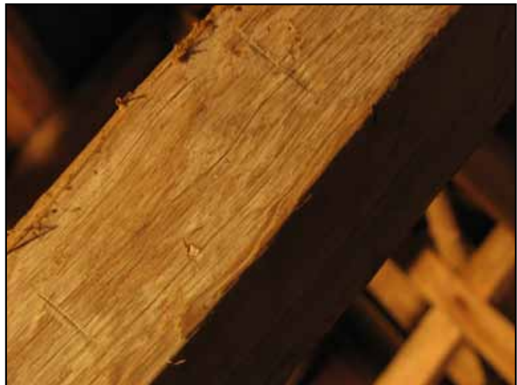
Två inristade runtecken, "I" och "B", på ett av stödben till takstol nr. 2.
