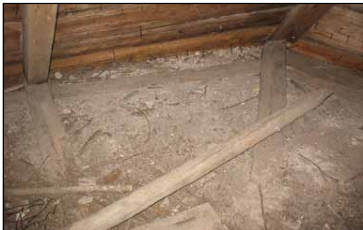
Remstycke och bindbjälkar inmurade i absidmuren.
