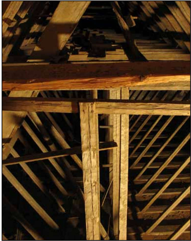
Långhusets taklag sett ovanifrån. Lägg märke till hur mittstolparna skiftar sida om styrbjälken, ett drag som även finns i Drevs gamla kyrka.
