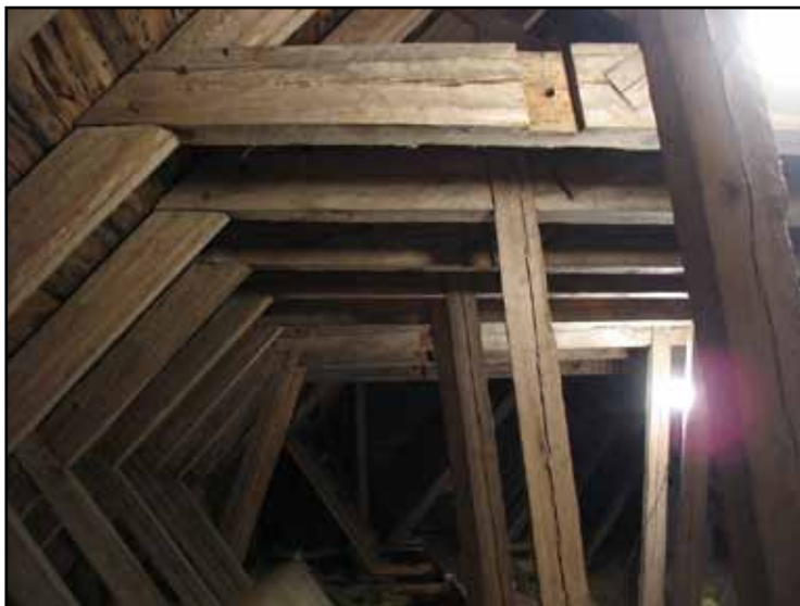
Detalj från väster. Hopfogningar är raka bladningar med en till två dymlingar. Alla ytor är sprättäljda.
