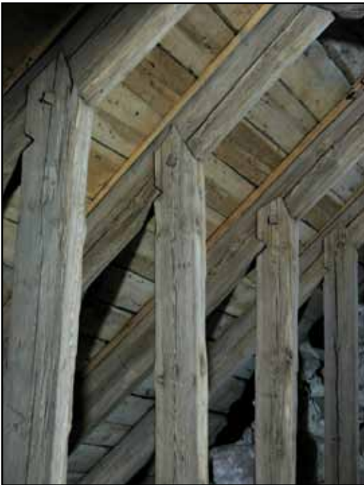
Bladningar med nacke och laxning mellan högben och stödben på södra sidan.
