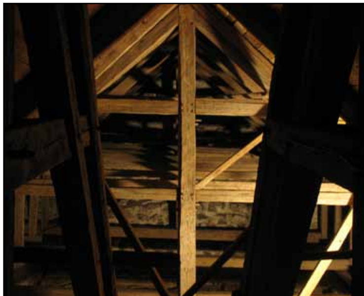
Taklaget österifrån. Den östra kungsstolpen visar att långstolen ej fortsatt längre, sannolikt på grund av ett murat eller timrat gavelröste till långhusets ursprungliga utsträckning.
