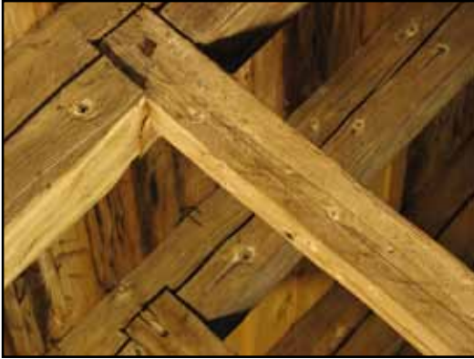
Hopfogningar med bladning och spik, ovan mellan högben och sparrar, till höger mellan de korsande sparrarna.
