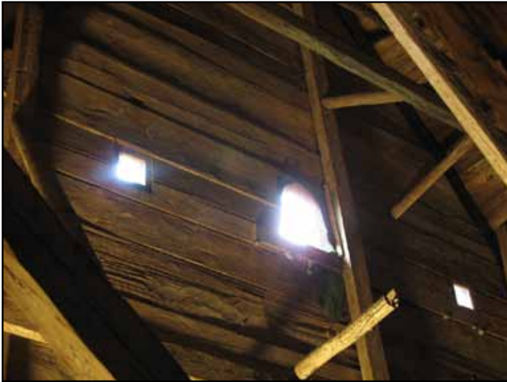
Det östra gavelröstet med gotisk fönsteröppning. Timret har disparat ytbehuggning.
