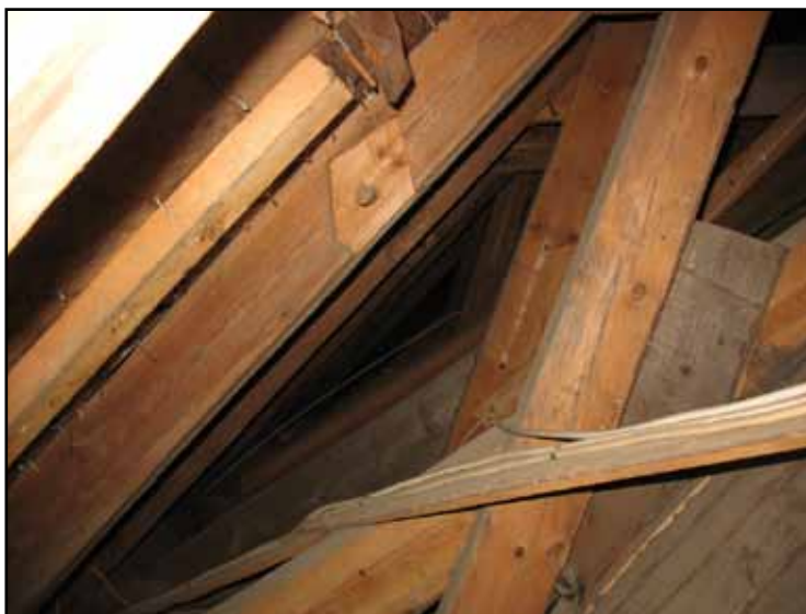
Urtag med nacke i högben för borttaget stödben i en knäbock.
