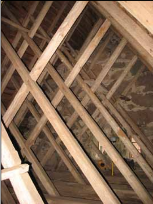
Långhusets taklag från nordost.
