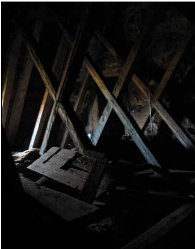
Korets taklag sett från sydväst.
