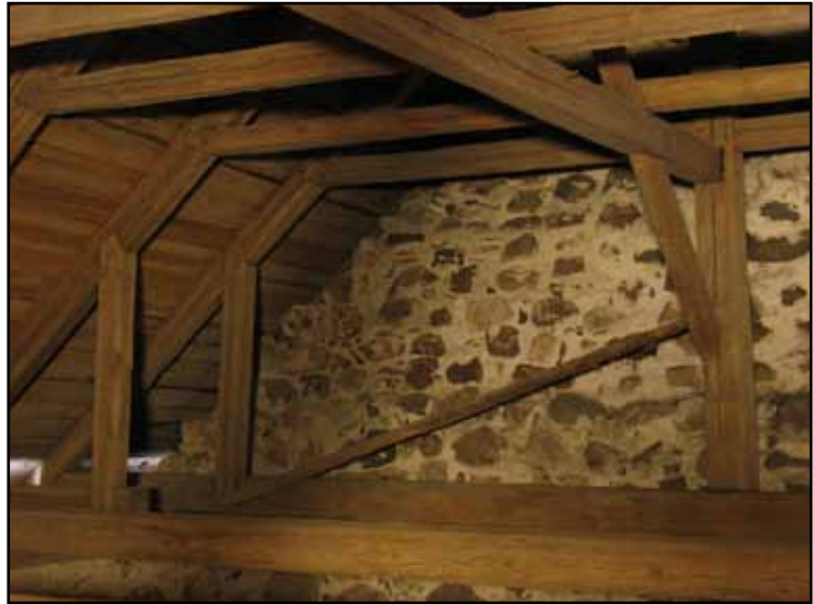
Nordvästra delen av taklaget över västra korsarmen. Till höger i bild den västra kungsstolpen.
