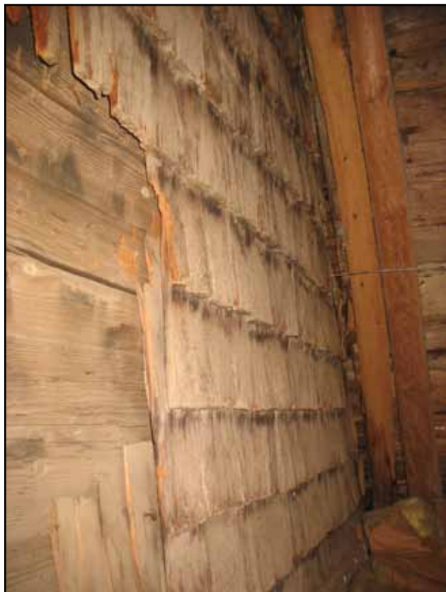
Det ursprungliga gavelröset till koret med delvis medeltida spånklädsel.
