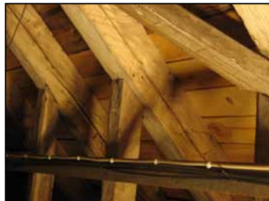
Vanlig lösning av kabeldragning på kyrkovindar.
