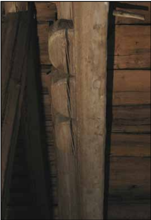
Högbenens sick-sackformade hopfogning. Den utsparde listens avbrott till höger därom vittnar om att där suttit en vertikal bräda som avslutning på gaveln.
