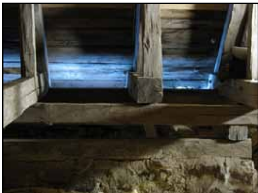
På insidan av norra muren är två troligen sekundära remstycken.
