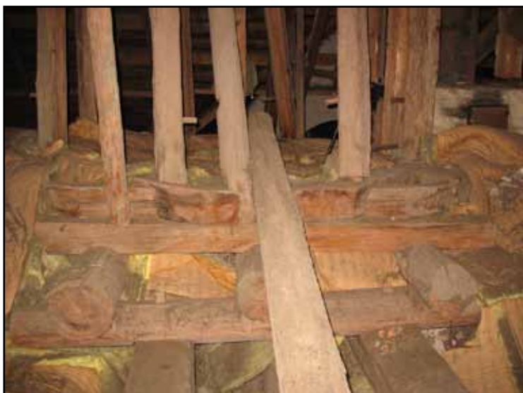
Konstruktionen till den utvändigt nedtagna takryttaren.
