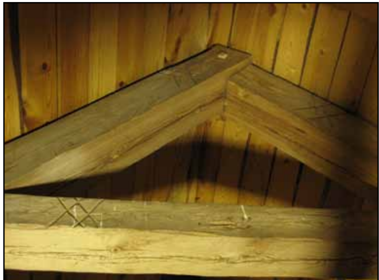
Två exempel på takstolarnas timmermärkning.
