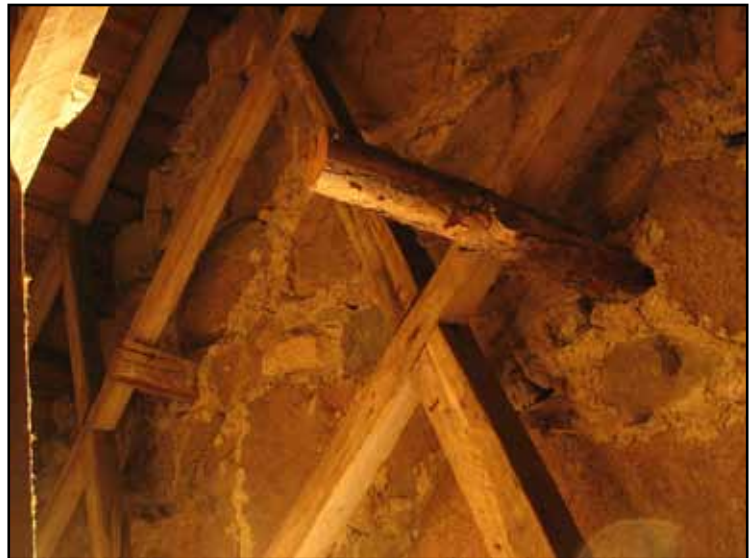
Möte mellan stödben, bladning med spik och tydlig sprättäljning. Ovan till höger syns bindbjälkarnas inmurning i murkrönet. Mellan bindbjälkarna syns puts.
