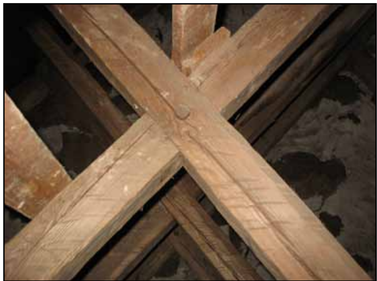
Sprättäljning och bladning med dymling på sparrar.
