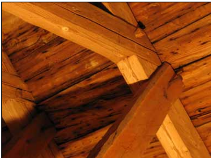
Hopfogning högben och hanbjälke.
