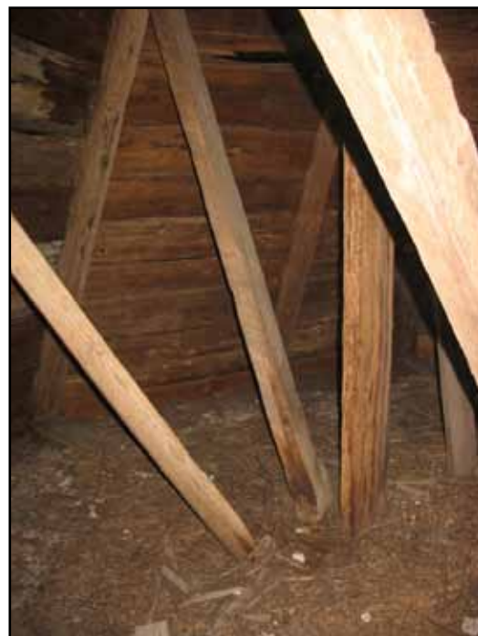
Mittstolpe och stödben på absidvinden.
