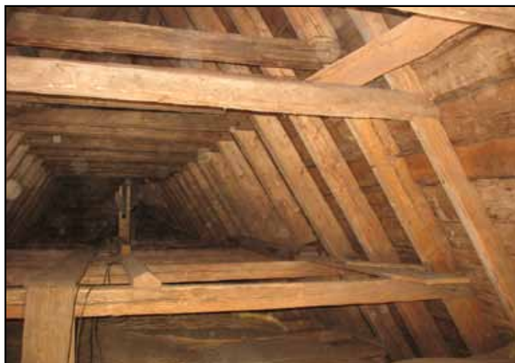
Långhusets takstolar är anpassade för 1700-talsvalvet.
