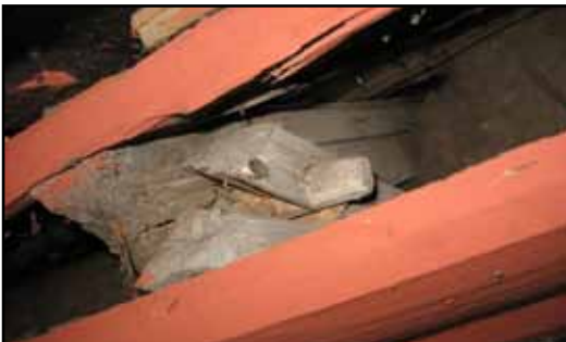
Skadad bladning mellan högben och tass på västsidan.
