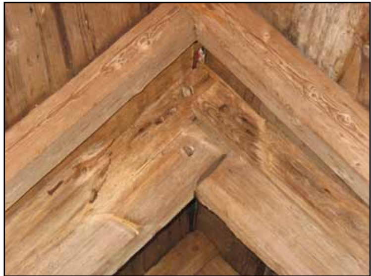
Högbenens sick-sackformade hopfogning. Den utsparde listens avbrott till höger därom vittnar om att där suttit en vertikal bräda som avslutning på gaveln.
