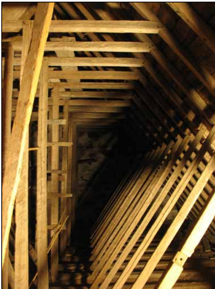
Södra halvan av långhusets taklag sedd från väster. Notera bladningen i det främsta stödbenet.
