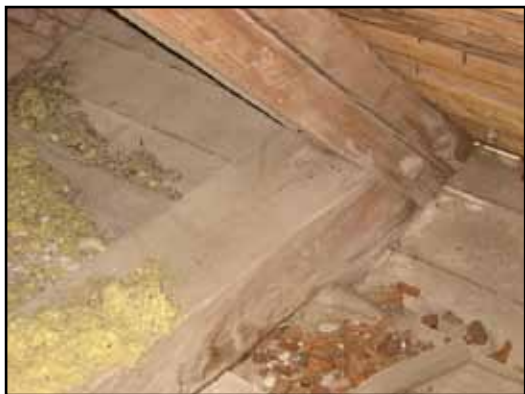
Möte mellan bindbjälke och högben.
