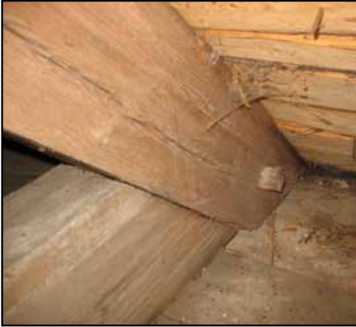
Möte mellan högben och bindbjälke.
