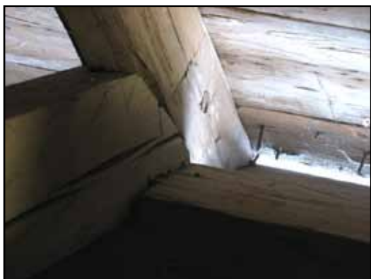
Möte mellan yttre remstycke, bindbjälke och högben på norra sidan. Varje del har timmermärke.
