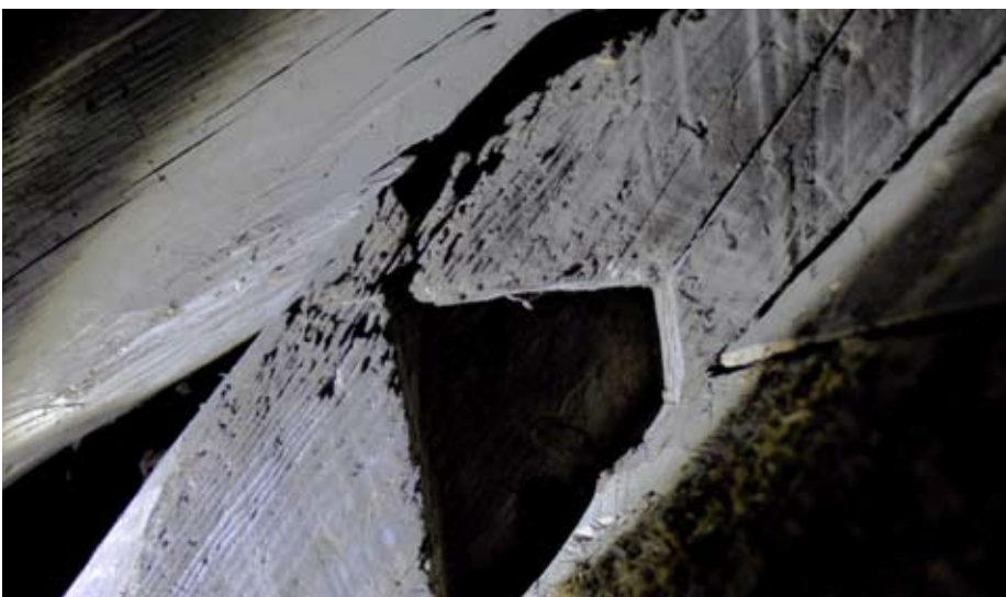
Rest av medeltida virke intill vindsluckan i Hagelbergs kyrka.
