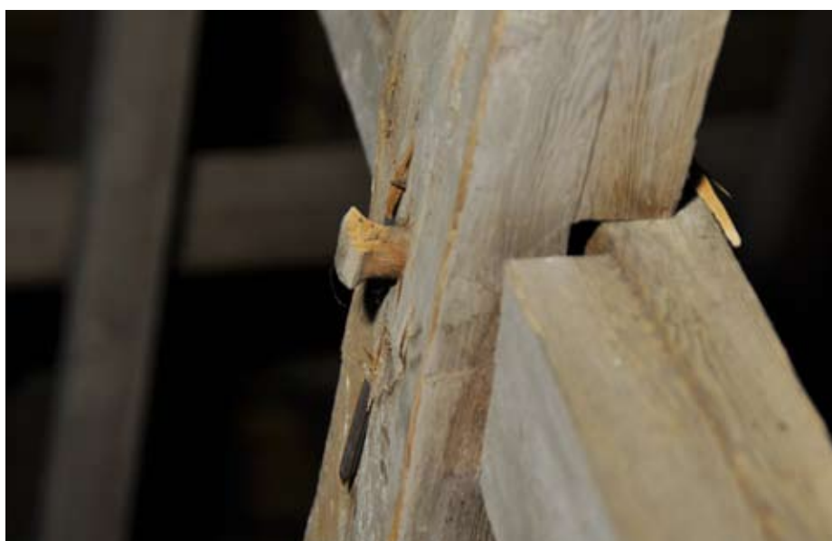
Spikskalledymling i Ekeskogs kyrka.
