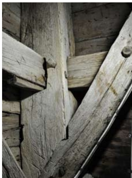
Knutar i ek och bjälkar med timmermansmärkning.
