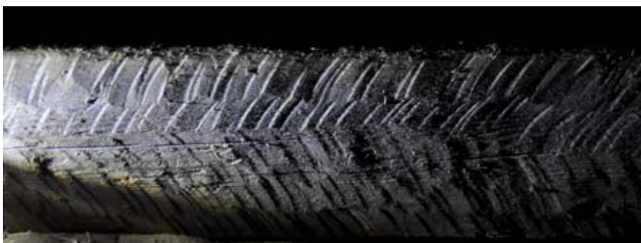
Sprätthuggen bindbjälke på kyrkans vind.
