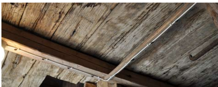
Det övre golvets undersida med återanvända brädor.
