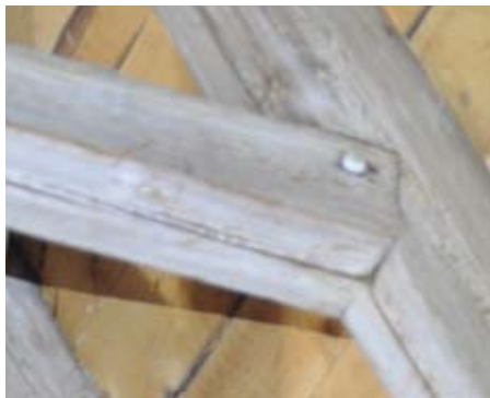
Knut mellan hanbjälke och högben ovan koret.
