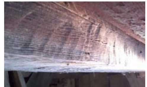
Spår av sprätthuggning – återanvänt virke?
