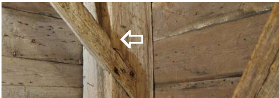
Hörnstolpen är ca 35cm i fyrkant, och krysträvorna är 15cm x 8cm. Det krävs virke av den dimensionen för att tygla klockornas krafter i nära 650 år. Knut med låsande nacke.
