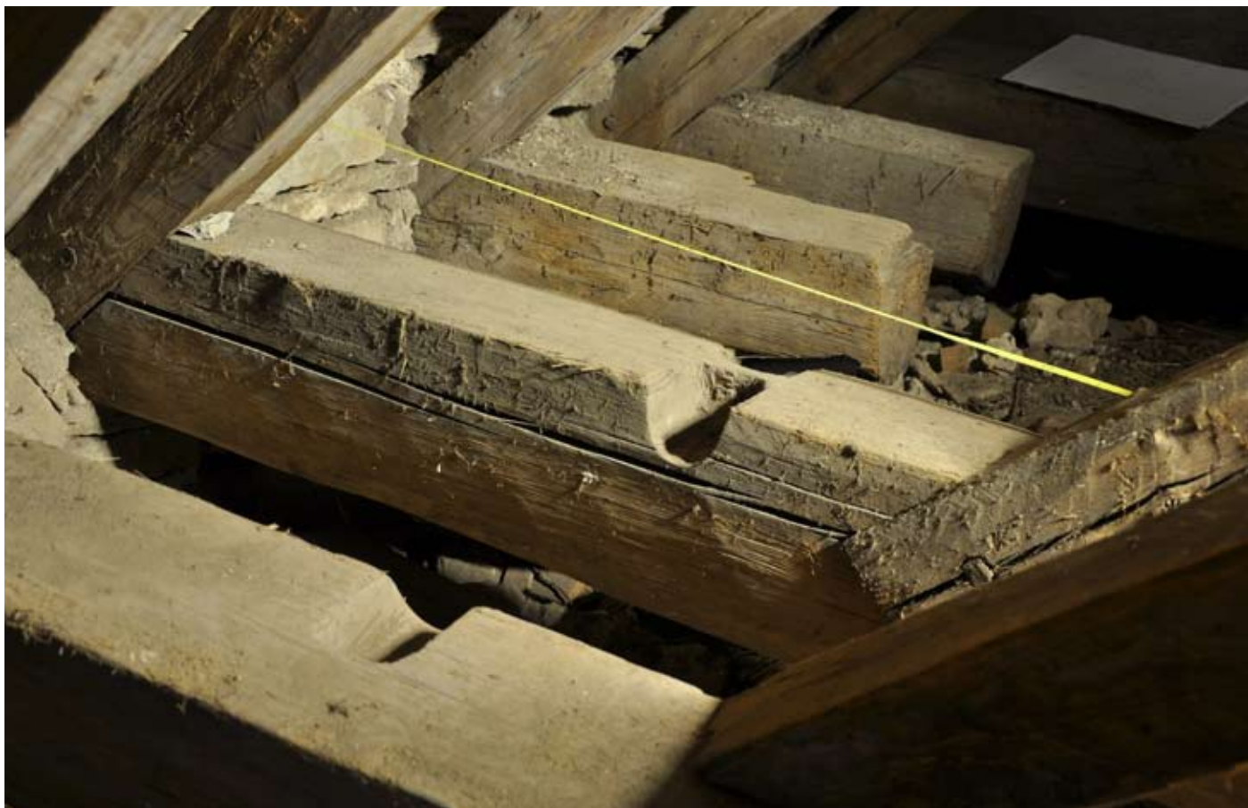
Gökhem kyrkas takstol är daterad till tidigt 1100-tal. Fördjupningarna i bindbjälkarna är troligen uttag för klockupphängning.
