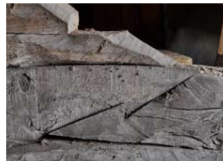
Snyggt blyxtskarvad dubbelsyll, sågat möter skrätt virke.
