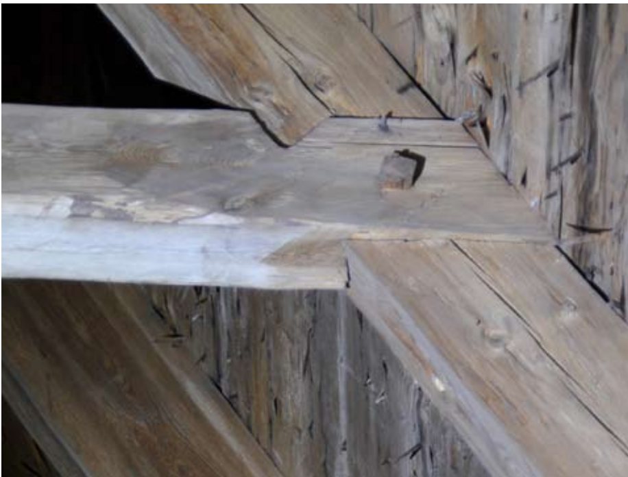
Långhuskonstruktionens knutpunkter med nacke i Breviks kyrka.
