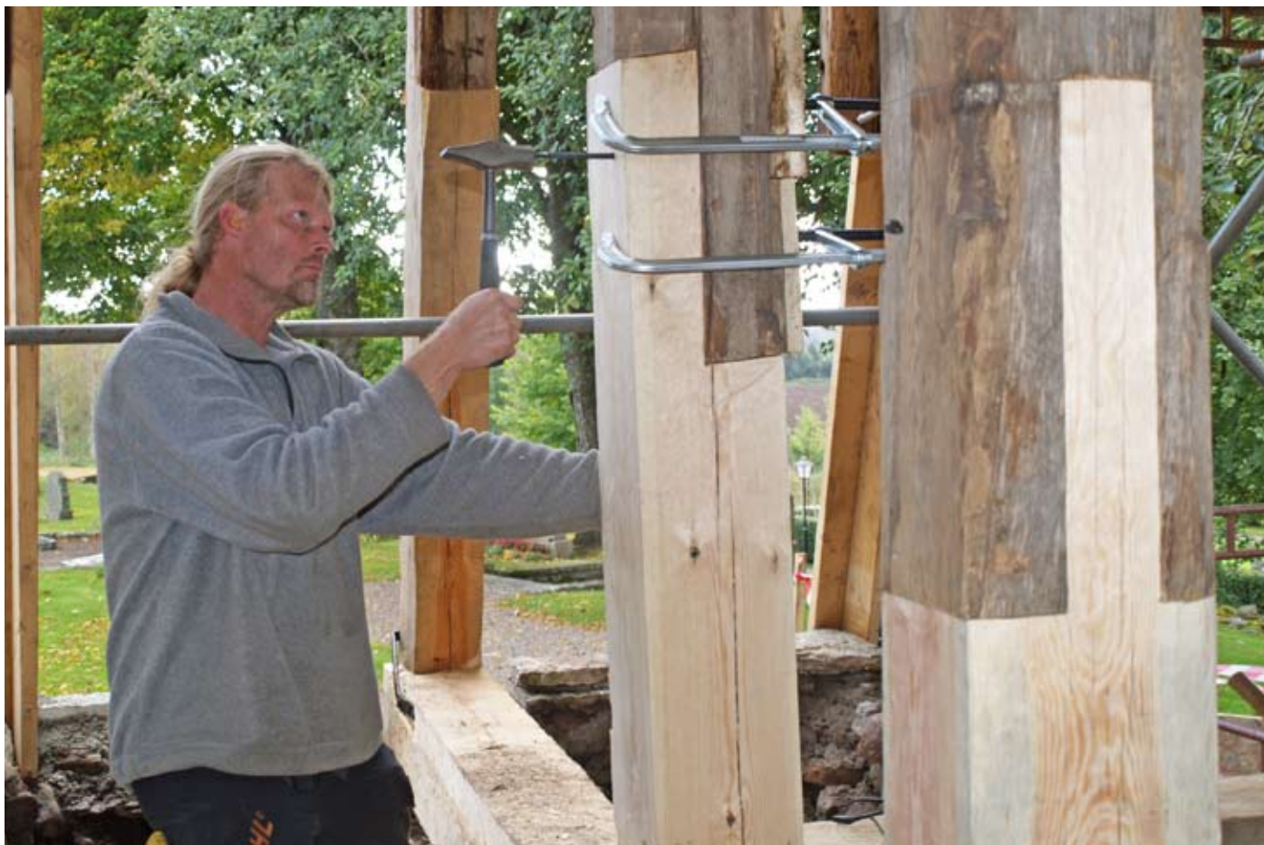
Bengt Bygdén skarvar högbenen på Marka klockstapel.
