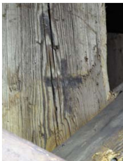
Inbränt kors på bjälke nära klockorna.
