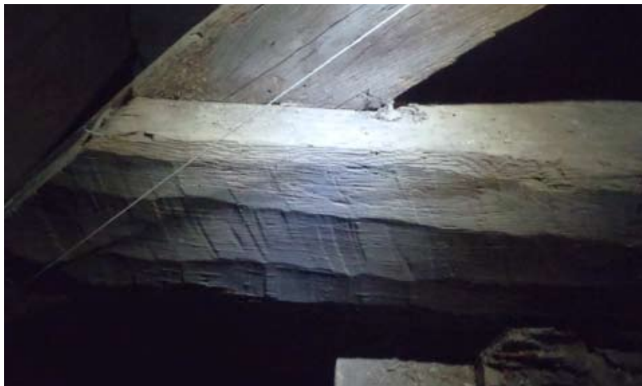
Sprätthuggning som lämnats orörd på bindbjälken där de inte kan synas från kyrkorummet, Forshems kyrka.
