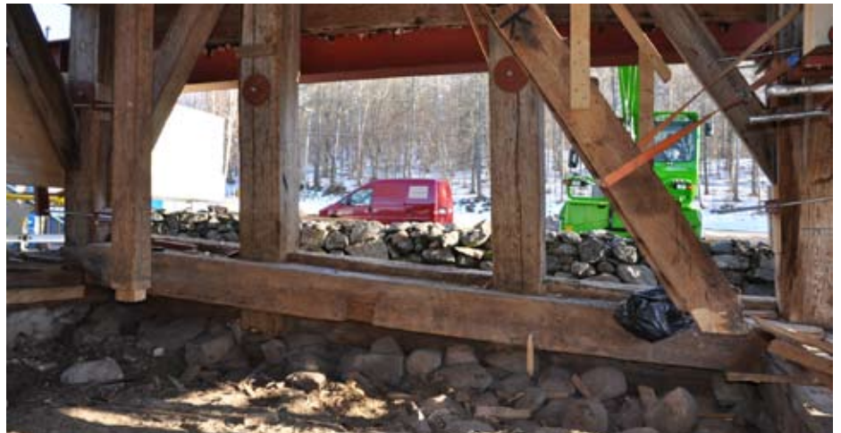
Pilarna markerar de medeltida benen, reparations-syllarna och betonggrunden.
