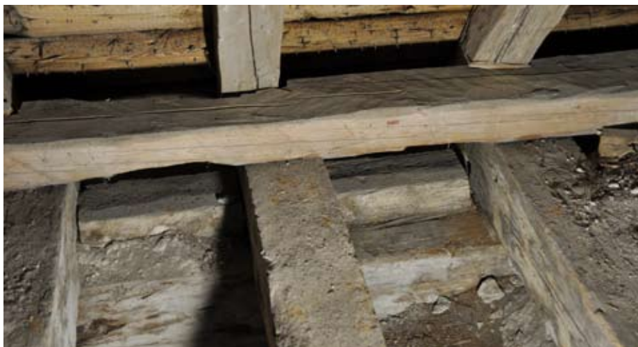
Remstycke och bindbjälkar i Ods kyrka.
