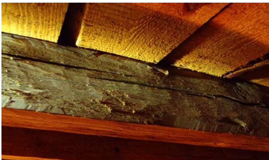
Bjälke med spår av efterbredbilning, Gökhem kyrka.
