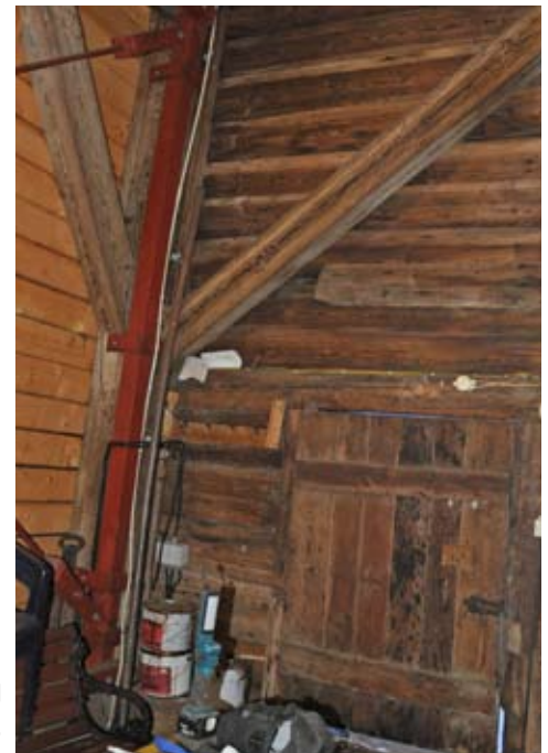
Förstärkning med järnbalkar och stag.
