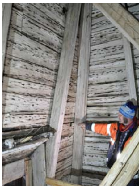
Trobräddor av asp med hål för byggnadsställning.
