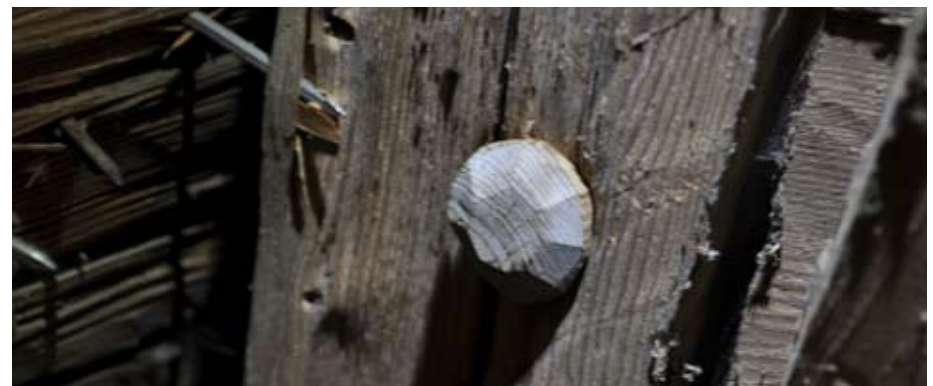
Dympling med huvud täjlt som spikskalle.
