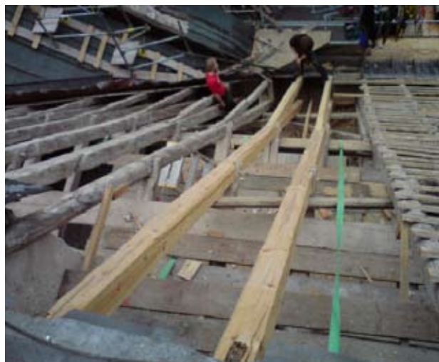
Avkapade högben med ”tillfälliga” iskarvade ben nedtill.
