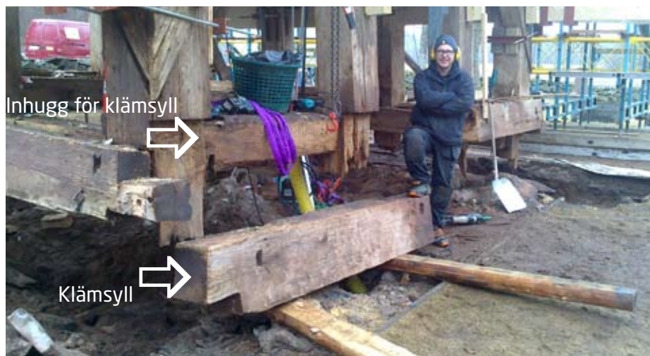
Bilden visar de inhugg för klämsyllarna som räddade tornet 1666.
