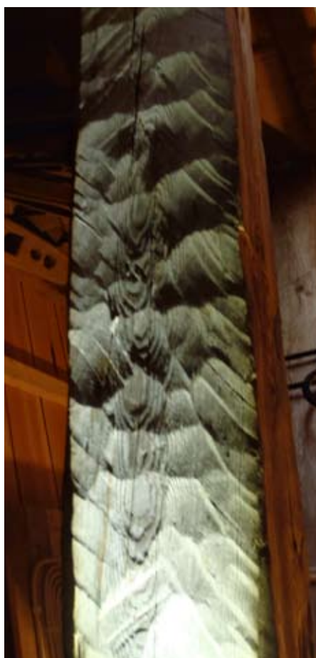
Hjärtstocken med svärdefinierad behuggning.
