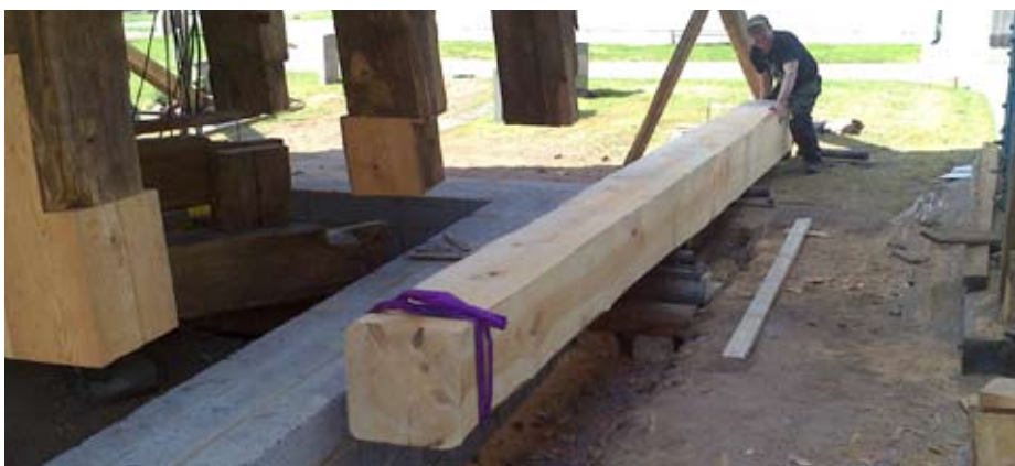
Här drar Jörgen syllan för handkraft på rullen sakta men säkert.
