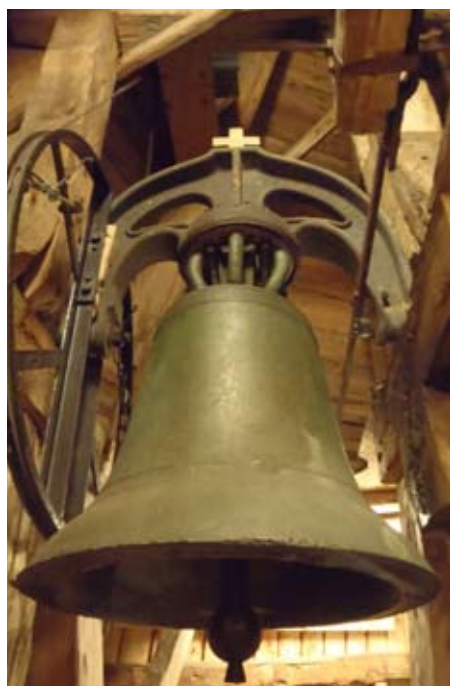
Klocka med gjutjärnsupphängning.
