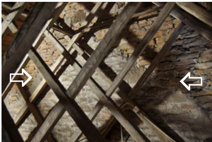
I gavelröset syns spår av ett äldre takfall.
