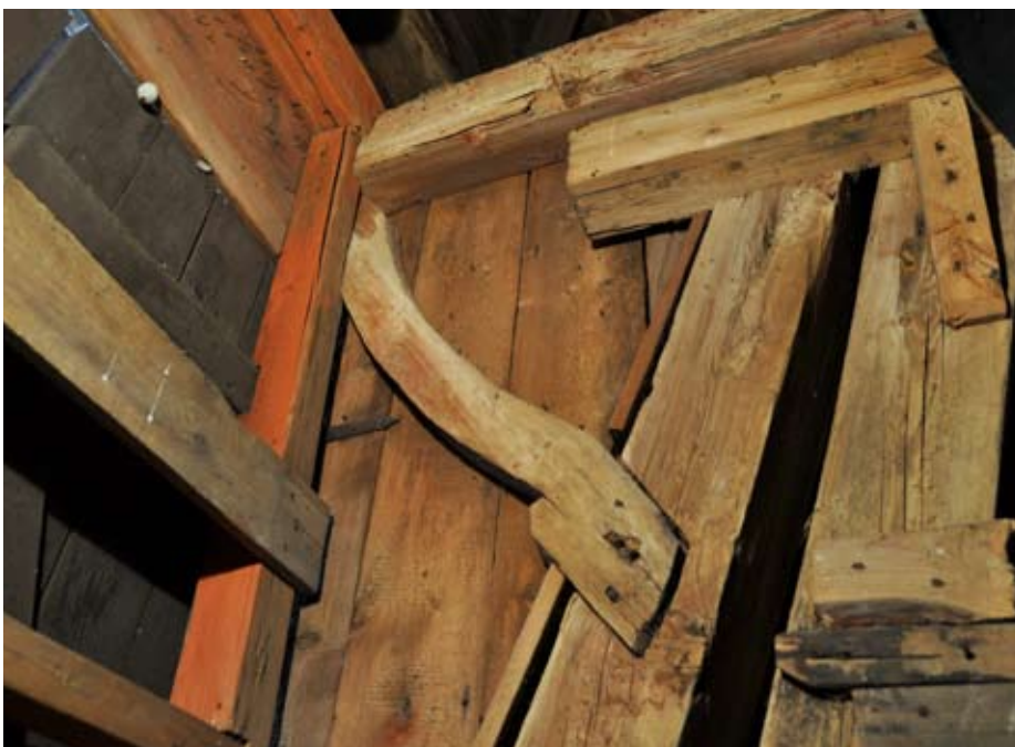
Spår visar att stapeln tycks ha plockats ned och åter rests.
