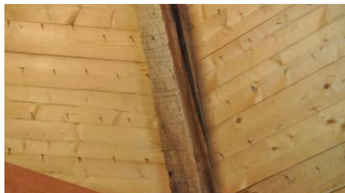
Tornhuvens bågformiga böj har sågats ur med handsåg (kransåg).
