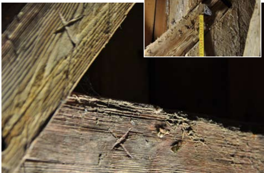
Timmermansmärkning med x. Vid tumstocken: "Hel-i-halvt"-husad knut.
