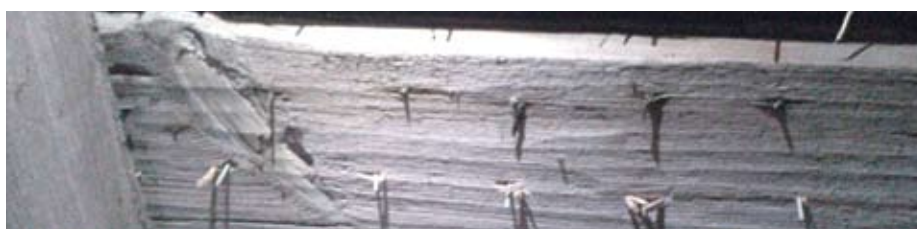
Trobrädor bearbetade med skave. De moderna spånspikarna har gått genom trobrädan.
