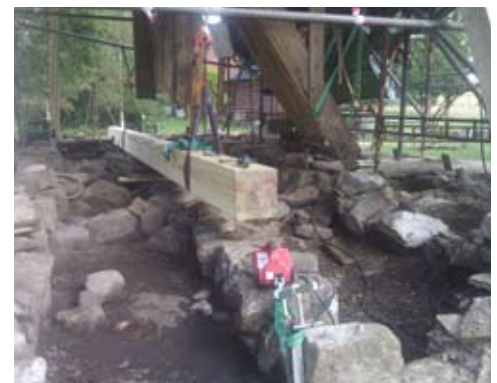
Äldre grundmurar trädde fram när grunden grävdes ut.
