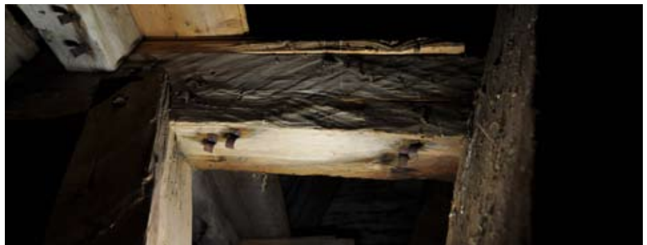
Slinhuggen/sprätthuggen yta och skarpa hörn på klockbjälken.
