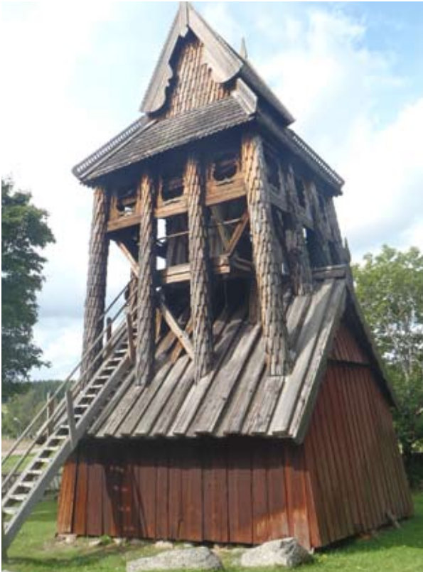
Trönö klockstapel, Hälsingland, är ett exempel på en, till stora delar, öppen tornstapel. Stapeln har en märklig uppbyggnad med spånklädda ben som till synes sticker upp ur en lada.
