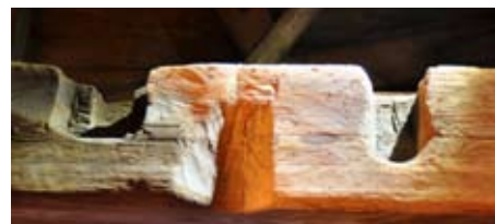
Gamla urtag för klockupphängning i stapelns bjälkar.
