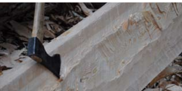
Sträva efter att använda samma arbetsmetoder som man använt när byggnaden uppfördes.
