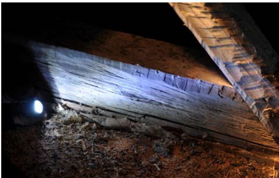
Exempel på "efterbredbilning". Med bilyxa borthuggen sprätthuggning.
