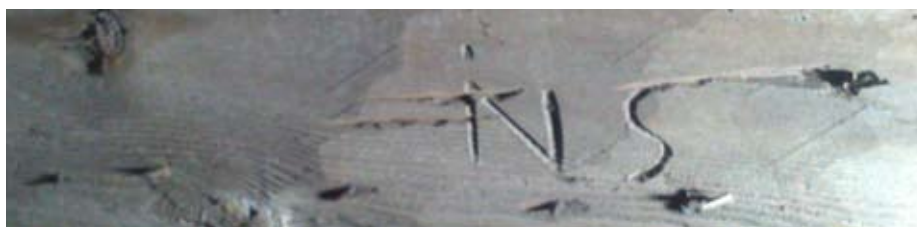
Timmermansmärkning på trobrädor.
