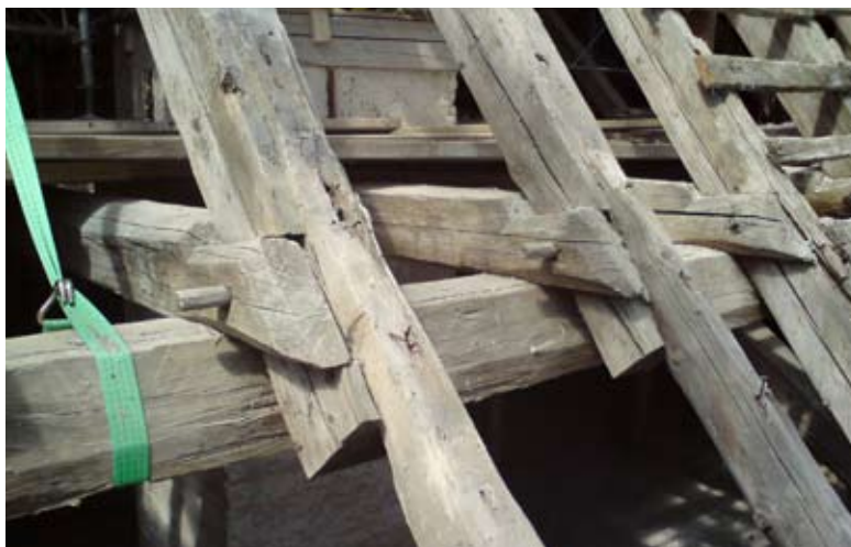
Avkapade högben med ”tillfälliga” iskarvade ben nedtill.
