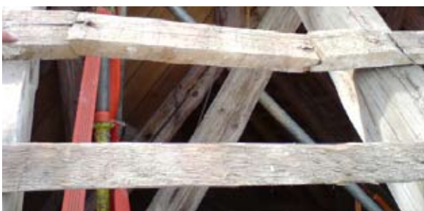
Extremt skarvad läkt berättar om tidigare underhåll.
