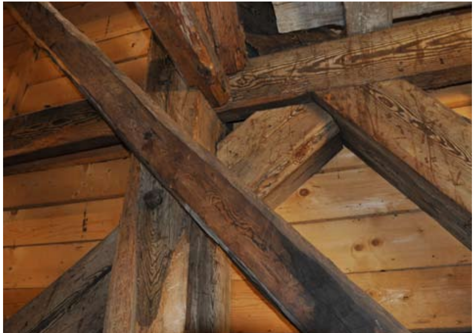
En sekundär sträva har satts dit framför konstruktionen som en extra förstärkning.
