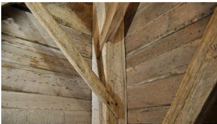
Knutpunkter med låsande nacke.
