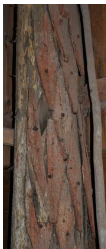
Rester av stavspån finns bakom locklistpanelen och även stolparna har varit klädda med spån.
