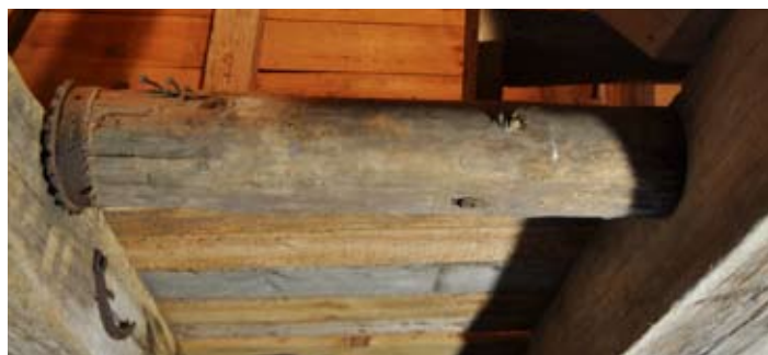
Nedan: Rullvinsch som troligen använts för att lyfta klockorna.
