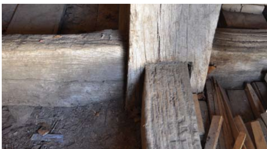
Syllkonstruktionens gaffelknut. Syllarna ligger i direktkontakt med marken.
