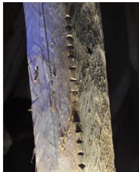
Hack i bjälke ovan koret.
