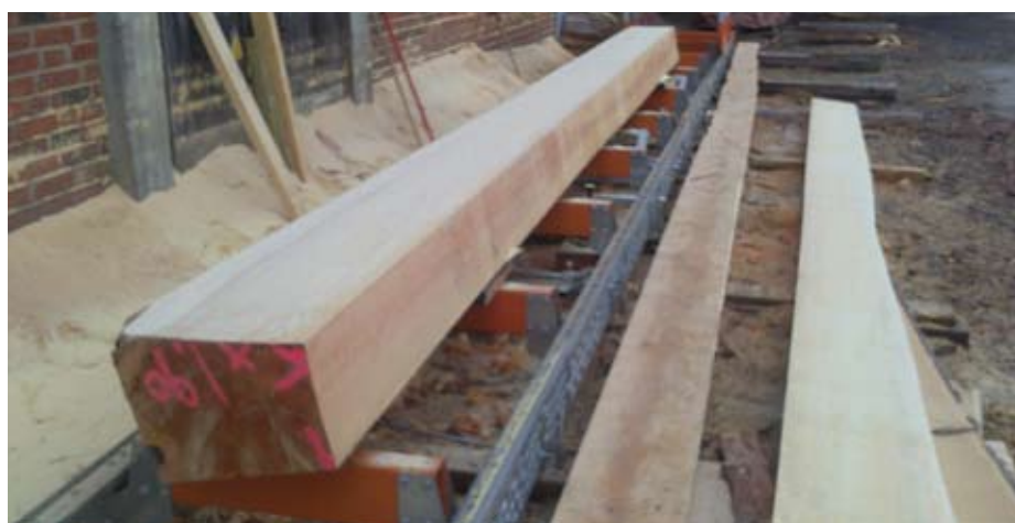
Här sågas en av de nya klämsyllarna konisk i formen.
