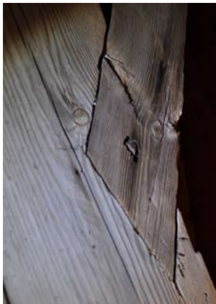
Konsolsträvorna är fästa med smidd spik.
