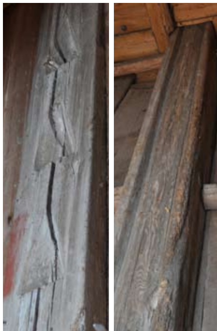
Klätterstocken, så kallad björnstock. Ena sidan har urtag för fötterna och andra sidan har rännor för fingrarnas grepp.
