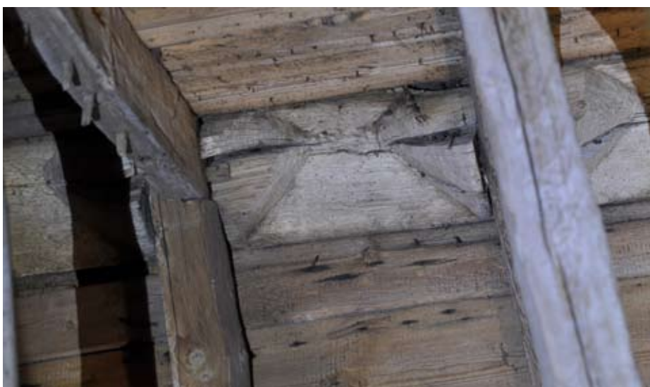
Genomgående dymlingar indikerar att en äldre taktro inte varit spikad utan dymlad fast. Numera är det spikade, ramsågade trobrädor. Taknockstock i ek.
