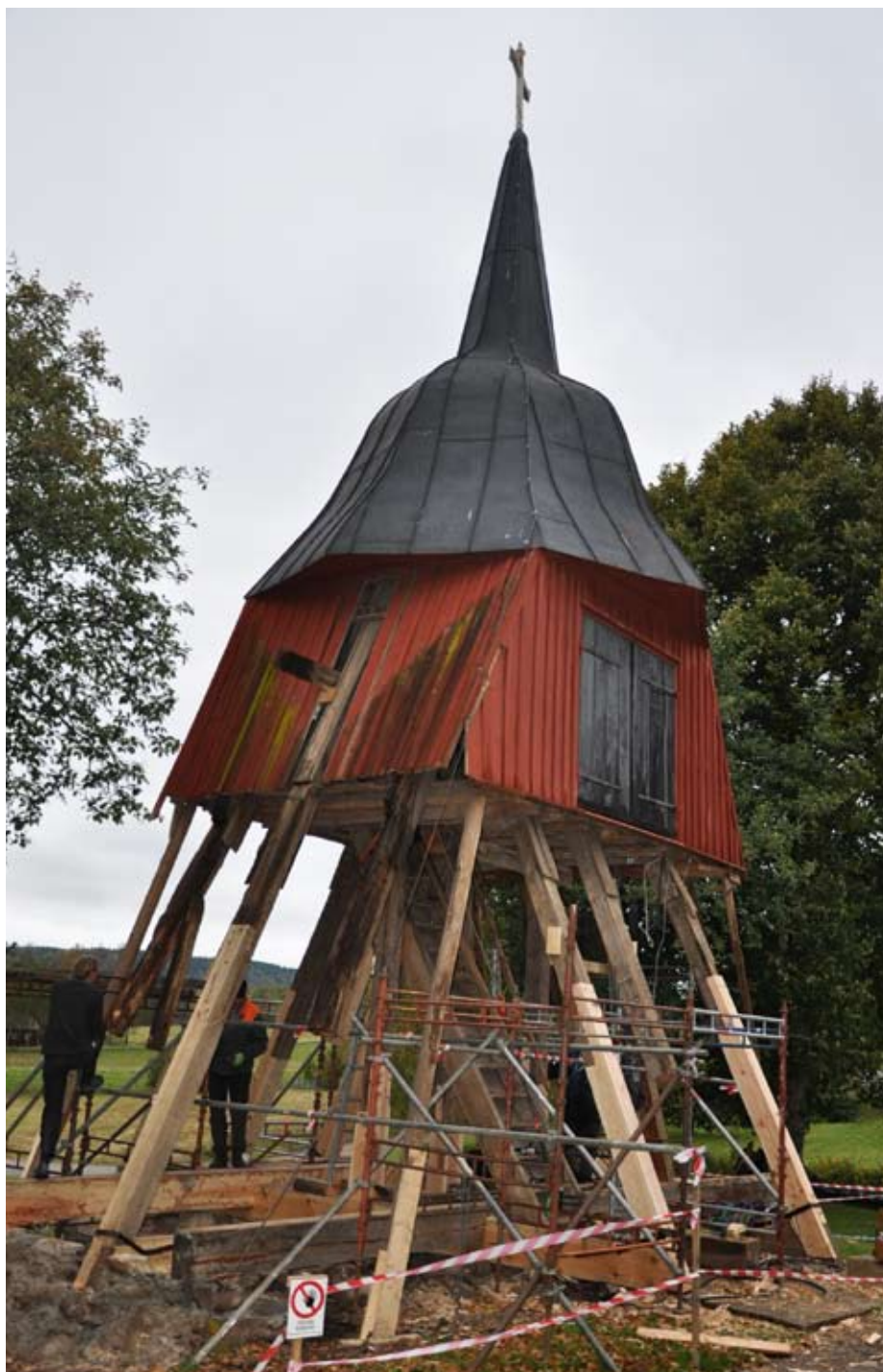
Marka klockstapel under renovering. Den rötskadade nederdelen ersattes med nytt virke.
