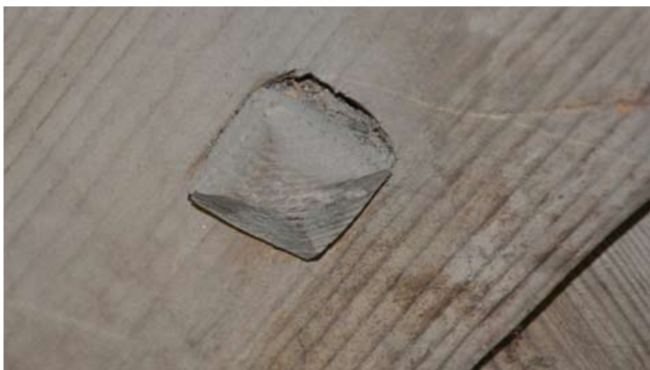
Spikskalle i trä formgiven som en järnspik med fasade kanter, Forsby kyrka.
