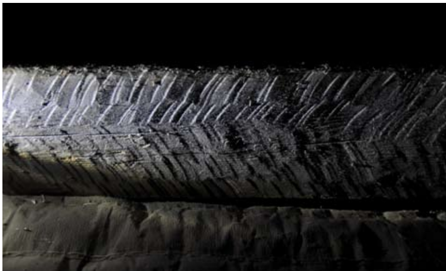
Sprätthuggning i band, bindbjälke, Skalunda kyrka.
