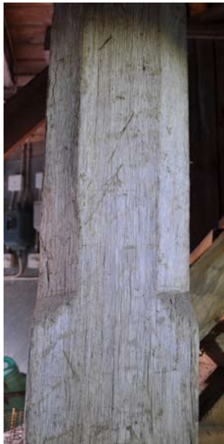
Fint fasade kanter på hjärtstocken.
