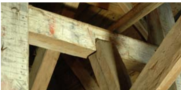
Återanvänt, bemålat timmer från äldre kyrka.
