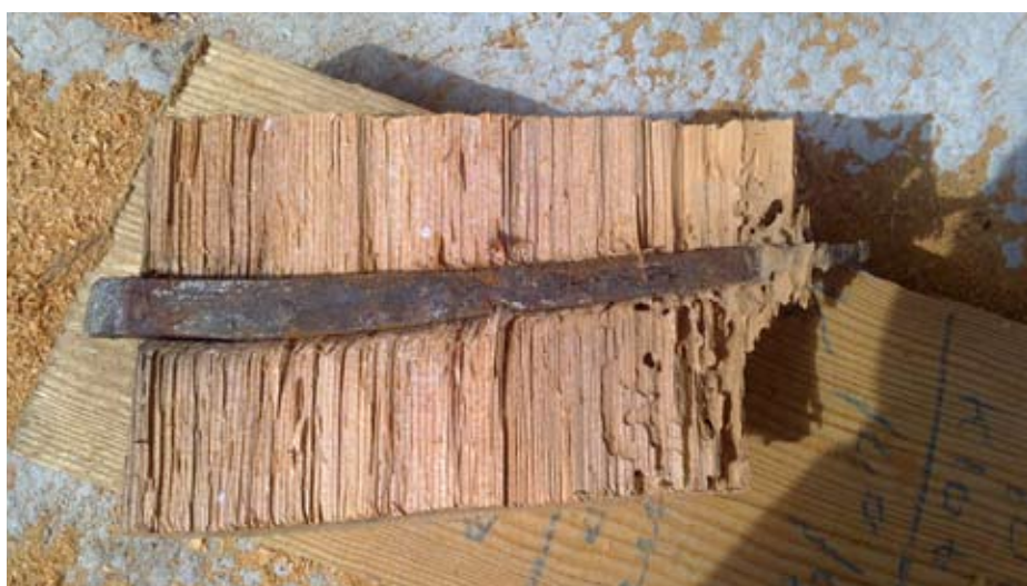
Spik från 1666 års reparation.
