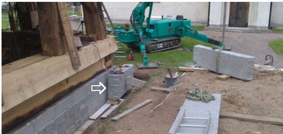
Luftspalt mellan lecablock och granitsockel.
