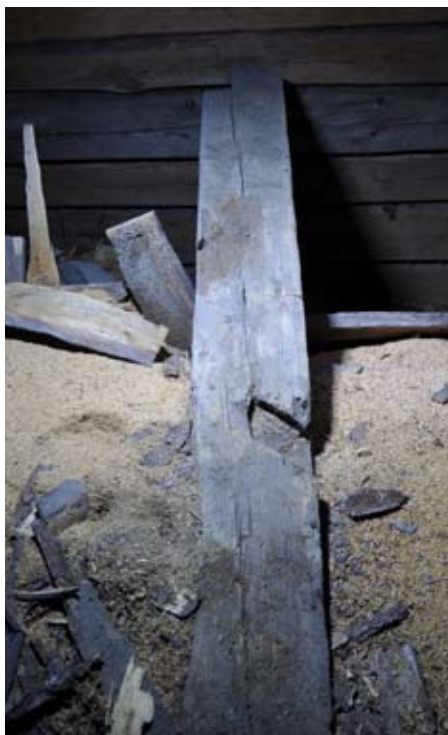
En återanvänd tidigmedeltida bindbjälke på kyrkvinden med urtag för stöttor.
