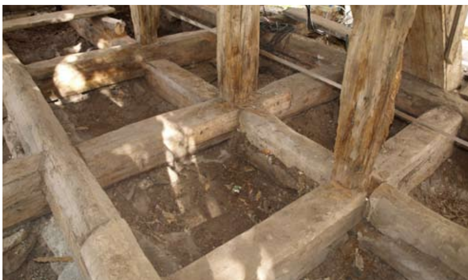
Marka klockstapel under renovering. Rötskadade syllar och mittstockar före demontering.
