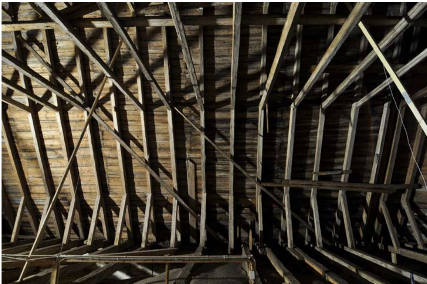
Långhusets vind, norra takfallet från insidan.
