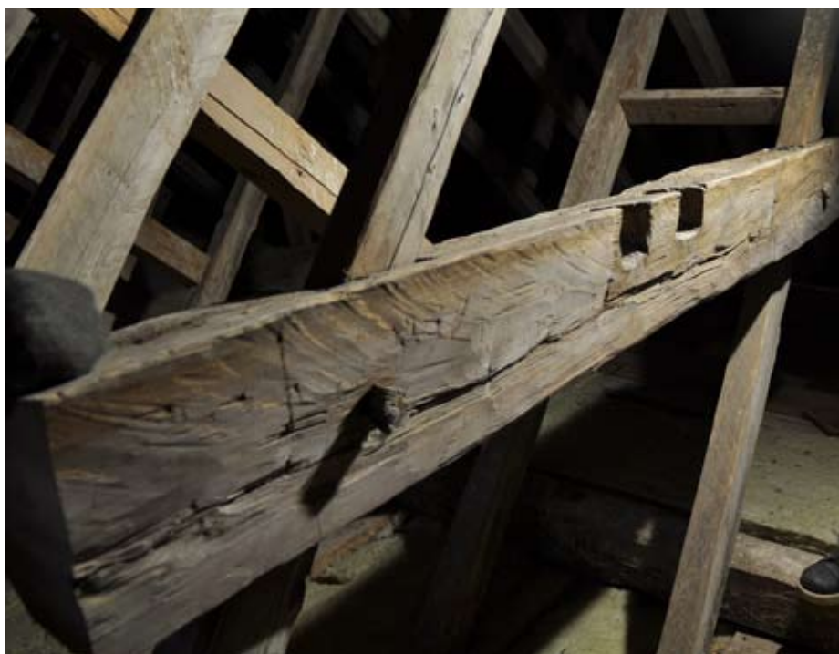
Trolig klockupphängningsanordning i takstol i Ekeskogs kyrka.
