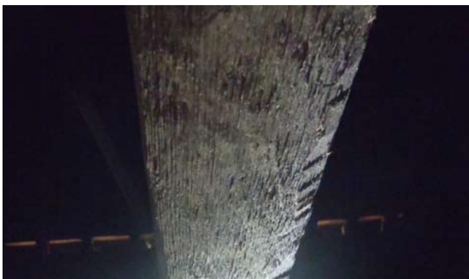
"Efterbreddbilad" sträva, Forshems kyrka.
