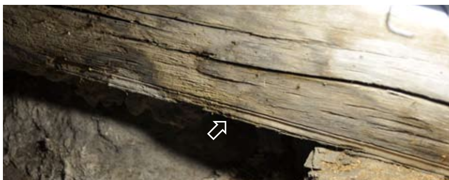
Bindbjälkarna på kyrkans vind har profilerade spår i nederkant.
