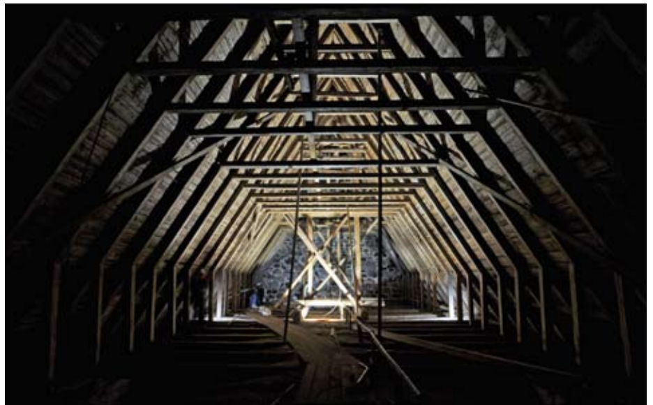
I mitten, i ljuset, syns fundamentet till takryttaren som funnits tidigare.
