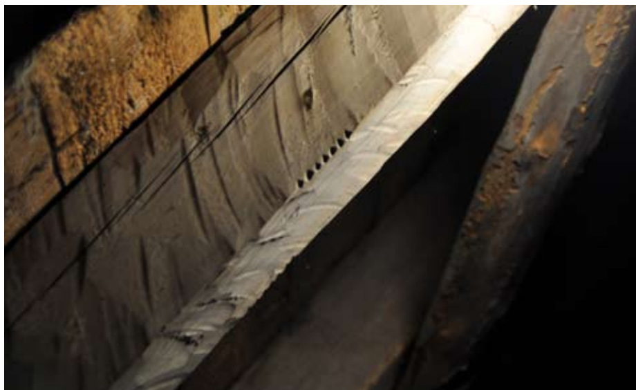
Takstol nummer 8 med timmermansmärkning. Ekeskogs kyrka.
