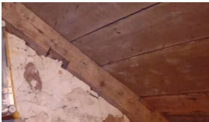
En återanvänd bjälke på kyrkans vind.
