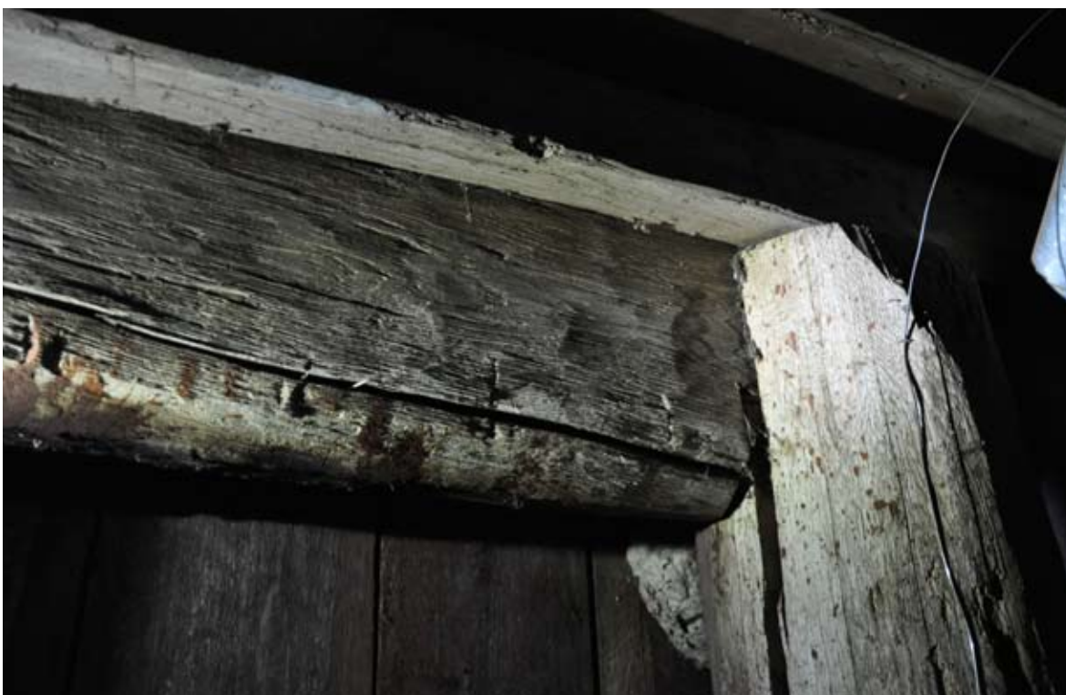
Den gamla och den nyare stapelkonstruktionen sida vid sida.
