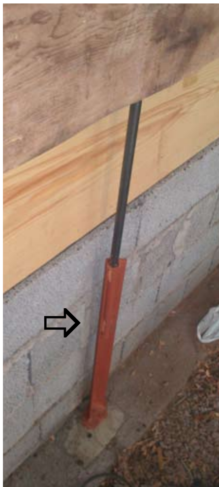
Det svetsade nedre förankringsjärnet.
