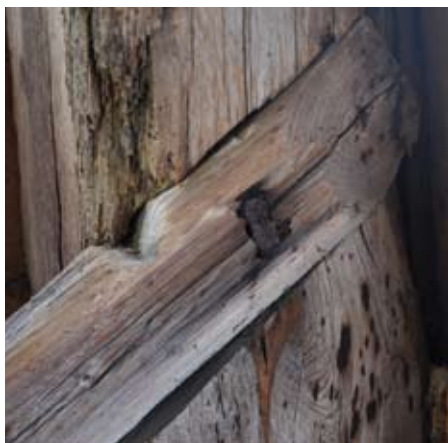
Möte tornben-kryssträvans övre del.
