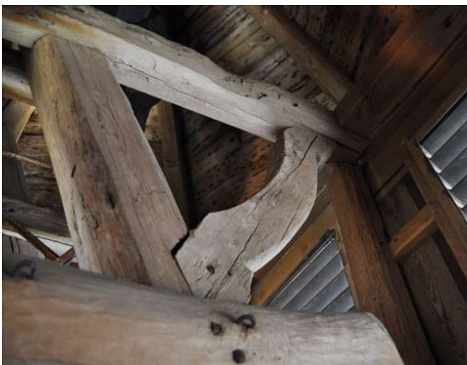
Konsolsträva med fin bågform.
