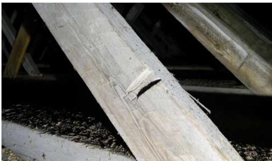
Spår av behuggningsprocess, klamphuggning i Marums kyrka.
