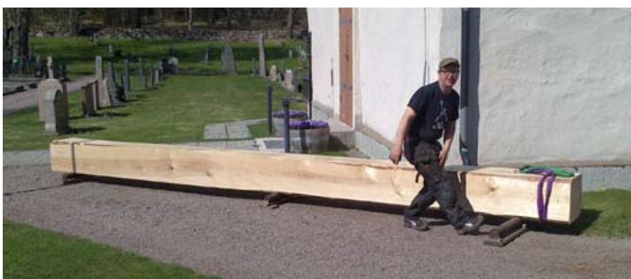
Här drar Jörgen syllan för handkraft på rullen sakta men säkert.
