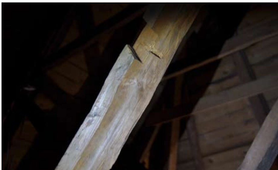
Återanvänd stötta i långhuset i Mofalla kyrka.
