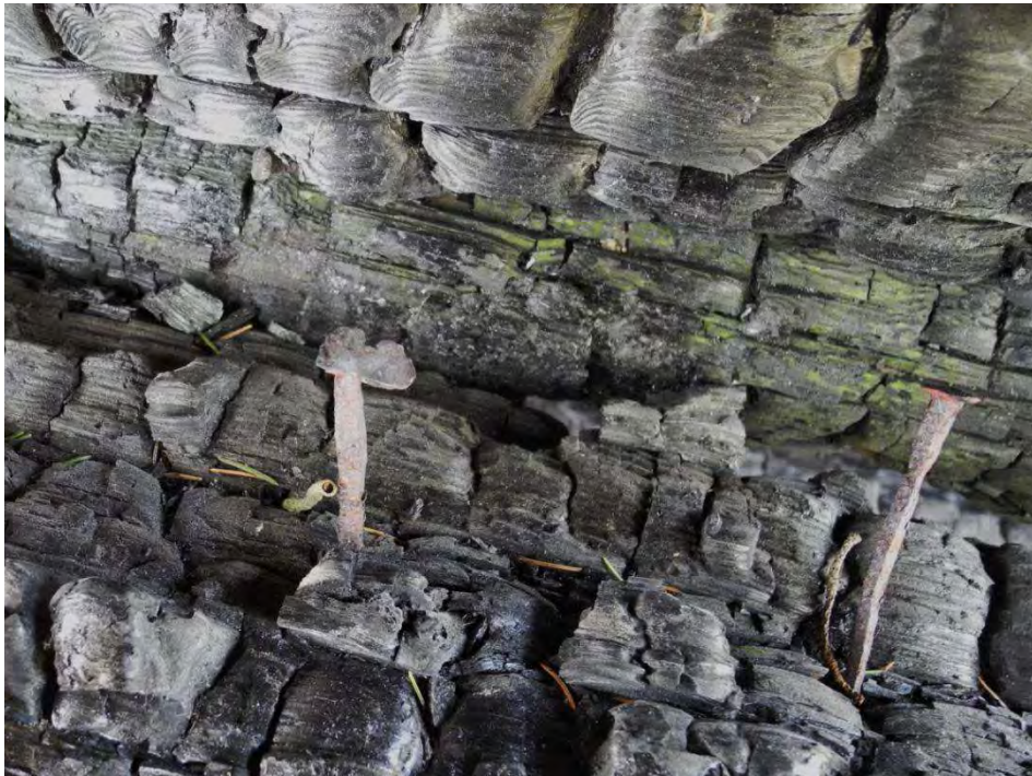
Fig. 25 Spikar typ 2 i brandrester med huvud parallellt med timret.
