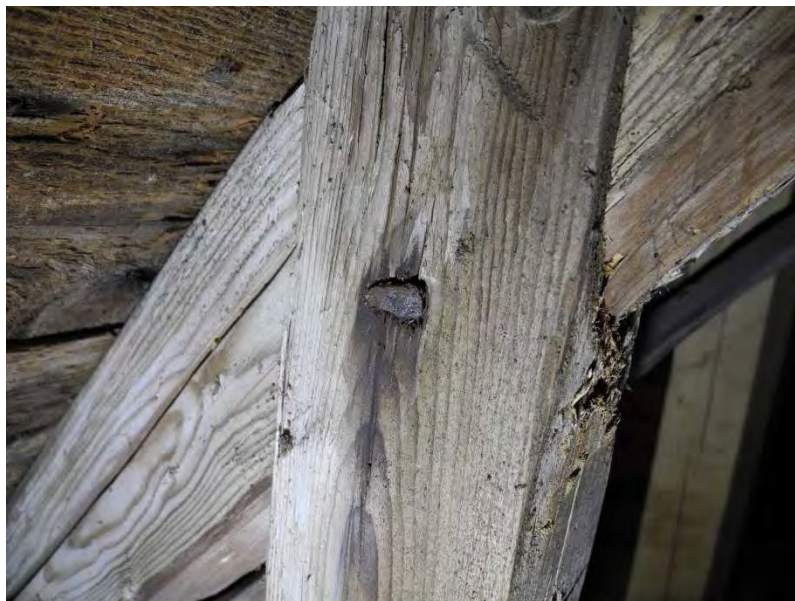
Fig. 21 Hedareds stavkyrka, spik typ 2 i takkonstruktion. 1500-tal.
