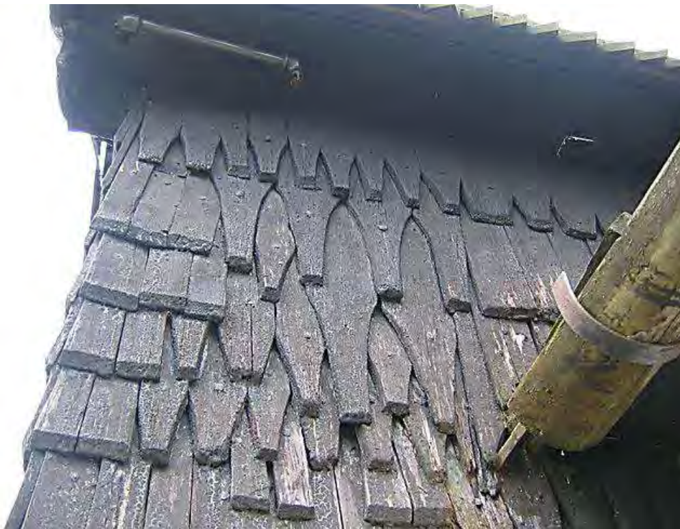
Fig. 20 Tångeråsa spånbeklädning med spikar motsvarande typ 1, datering ca år 1300.
