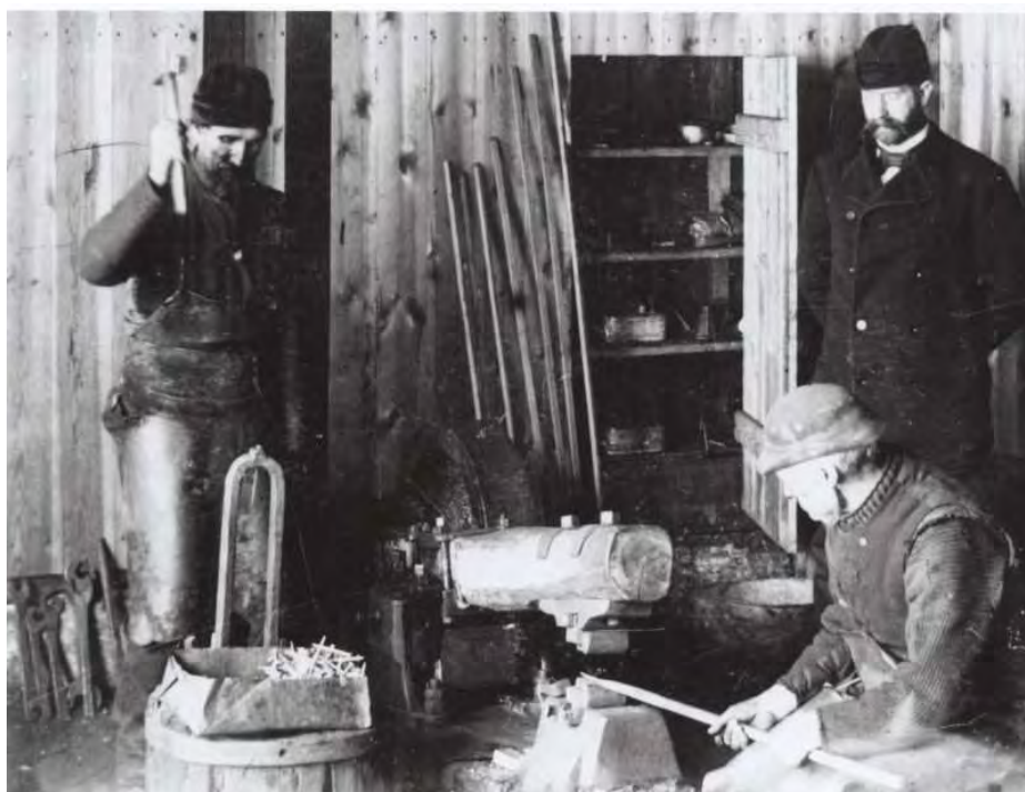
Fig. 4 Smide av spik i vattenhammare. Huvudet slås i docka, Ängelsfors spiksmedja.
